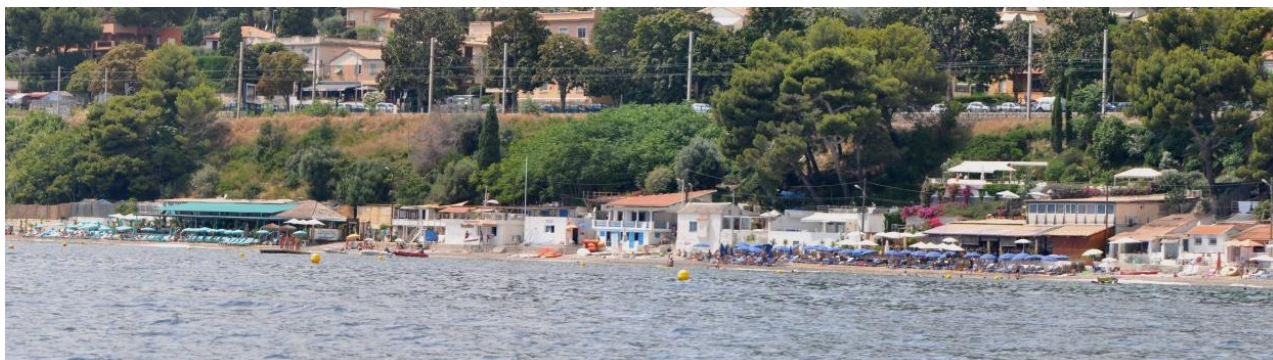
Illustration 57 : Etablissements balnéaires et constructions, plage d'Eze
